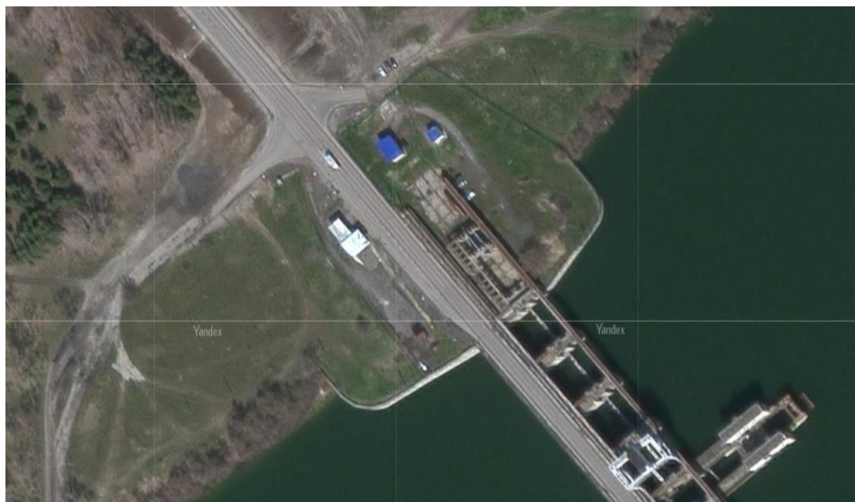
Рисунок 2 – Вид со спутника на водосливную плотину
