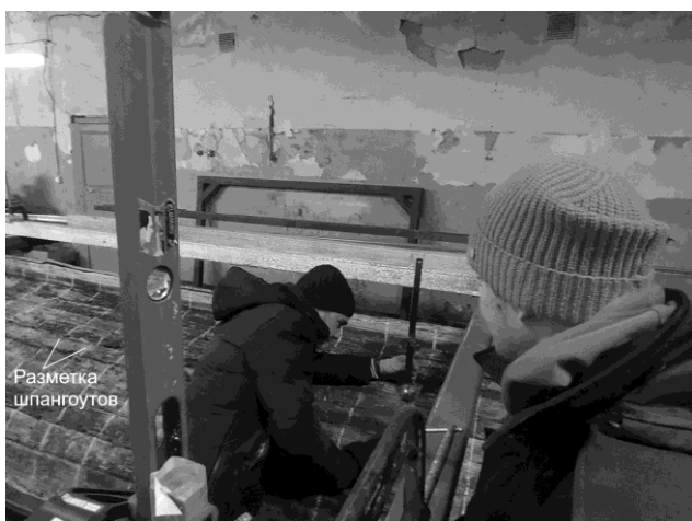
Рисунок 2 – Момент измерений положения точки поверхности яла в поперечной плоскости
