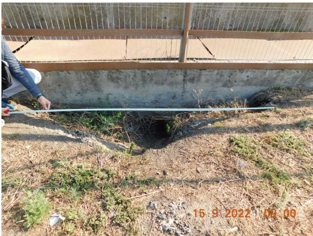
Рисунок 3 – Вид со стороны автотрассы на подкрановую эстакаду водосливной плотины (свайный створ 11-12).
